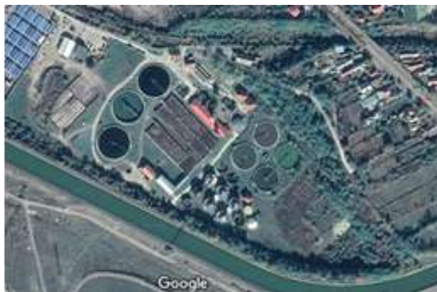
Fig. 4.47. Stația de epurare apă uzată Piatra Neamț
