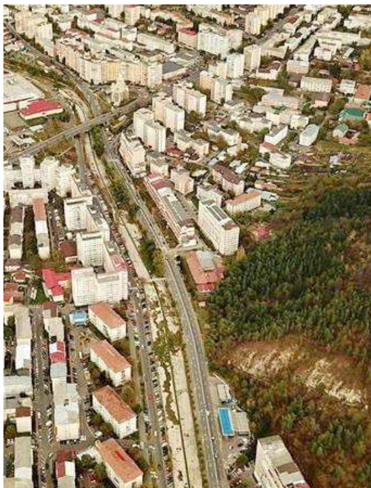
Vedere spre latura de nord a ansamblului de locuinte situat pe Strada Orhei
